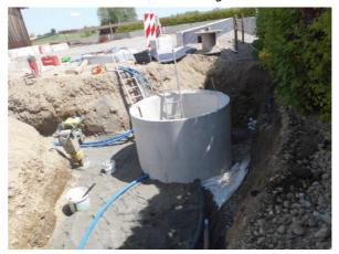
Parallel dazu wurden die Leerrohre und die Wasserleitung von den Kameraden der Freiwilligen Feuerwehr und den freiwilligen Mitarbeitern der Gemeinde für die neue Hauptwasserversorgung in den Graben verlegt, mit Sand umhüllt und die Rohrgräben verfüllt und verdichtet.
