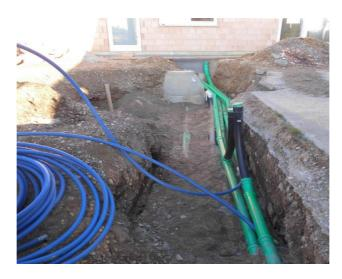
Ein paar Tage später wurde der Graben für die neue Hauptwasserversorgung vom Rathaus und Erweiterung Feuerwehrgerätehaus hergestellt sowie ein Hydrantenschacht als Verteiler für die Wasserleitung versetzt.
