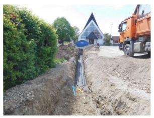
Mittlerweile sind die Tiefbauarbeiten für den Versorgungsbereich (Wasserleitung/Abwasser/Leerrohre) vom Rathaus und der Erweiterung des Feuerwehrgerätehauses abgeschlossen, somit kann die Luftwärmepumpe auf der Kellerdecke aufgestellt werden und im Keller die erforderlichen Installationen erfolgen.
